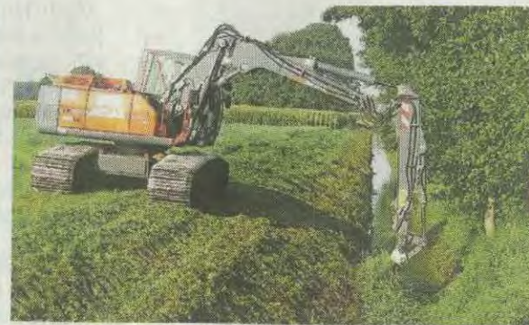
Die Räumung mit dem Mähkorbbagger an einem Wasserlauf gehört zu den jährlichen Unterhaltungsarbeiten.
