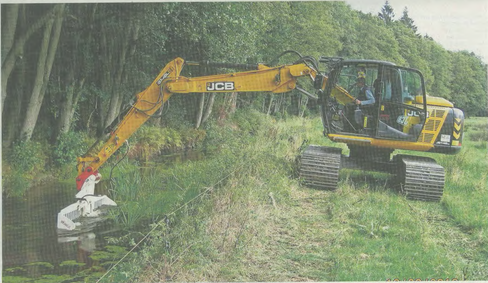
Ende August, Anfang September werden wieder Gräben und Bäche geräumt. Der Bagger muss genügend Platz haben, der Räumstreifen frei sein.
