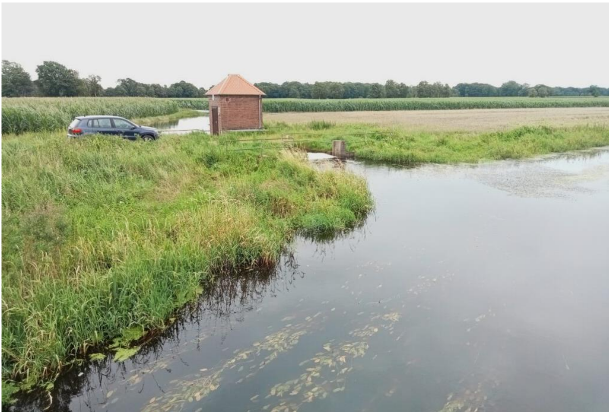
Abb. 65: Über dieses Pumpwerk entwässert der Staupolder Mehedorf-Süd in die nahezu bordvolle Wallbeck. Am 13.8.2023, als dieses Foto entstand, stand das verunreinigte Wasser noch bordvoll in dem Poldergraben (Foto: UHV Untere Oste).
