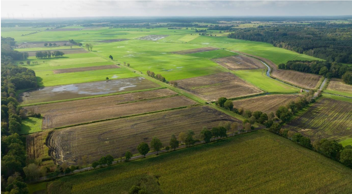
Abb. 64: Blick auf die am 10. Oktober 2023 teilweise noch überschwemmten Grünlandflächen am Staupolder Mehedorf-Süd (Foto: F. Möllers / AVN). Am rechten Bildrand ist das Pumpwerk an der Mündung zur Wallbeck zu erkennen.
