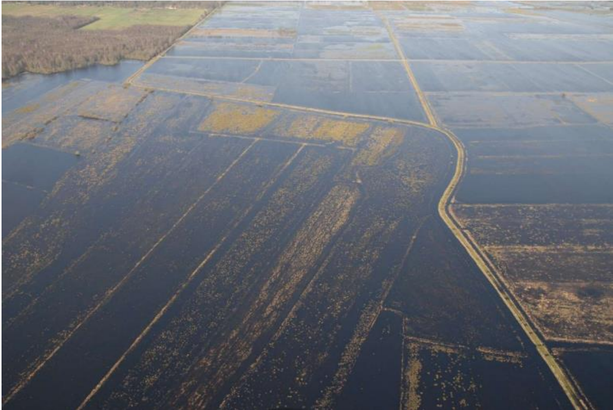
Abb. 73: Geflutete Retentionsräume in der Hammeniederung (älteres Foto, nicht von 2023!; Foto: GLV Teufelsmoor 2019)
