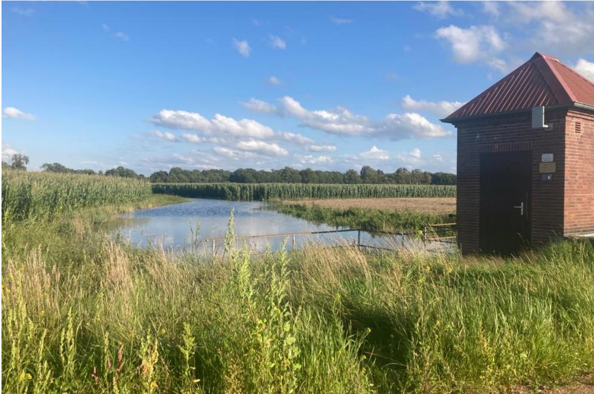
Abb. 66: Randvoller Staupolder Mehedorf Süd & Pumpstation an der Wallbeck, 13.8.2023 (Foto: AV Alfstedt)
