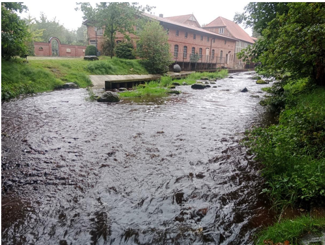
Abb. 47: Die Sohlgleite in Sittensen brachte eine deutliche Erhöhung der Sauerstoffgehaltes, der aber weiter stromab wieder auf für Salmoniden tödliche Werte fiel (17.8.2023, Foto: Ralf Gerken / AVN).
