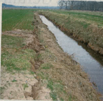
Zu dicht geackert: Die Böschung der Otter im Bereich Byhusen sackt ab.
